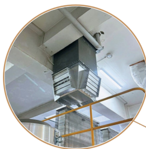
Nawiewnik wieloboczny trójstronny
