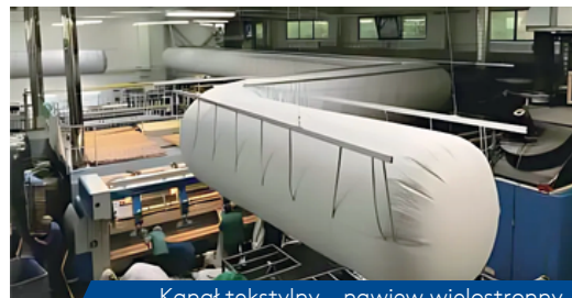
Kanał tekstylny – nawiew wielostronny, mikroperforacja dostosowana do stref przebywania ludzi
