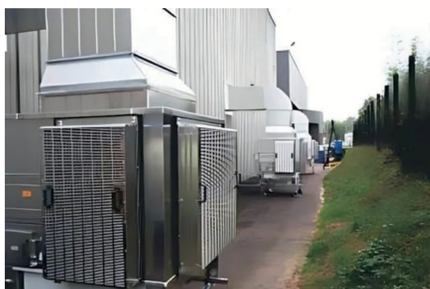
CoolStream S – podłączenie kanału wentylacyjnego od góry, stosowane dla jednostek montowanych obok budynku
