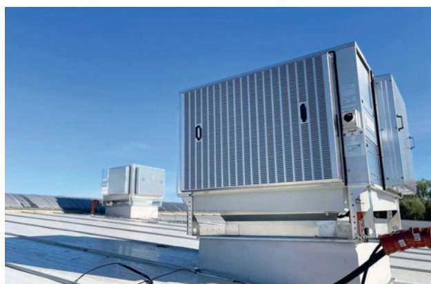
CoolStream S – jednostka nawiewna z podłączeniem dolnym wraz z wywiewem mechanicznym typu Coltair
