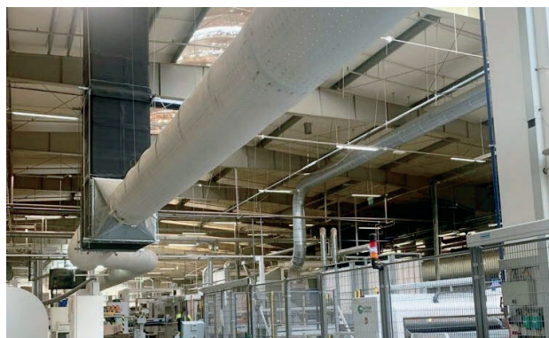
Kanał tekstylny – nawiew jednostronny z dyszami dalekiego zasięgu
