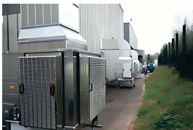
CoolStream S – połączenie kanału wentylacyjnego od góry, stosowane dla jednostek montowanych obok budynku
