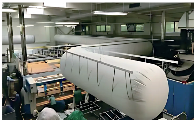
Kanał tekstylny – nawiew wielostronny, mikroperforacja dostosowana do stref przebywania ludzi
