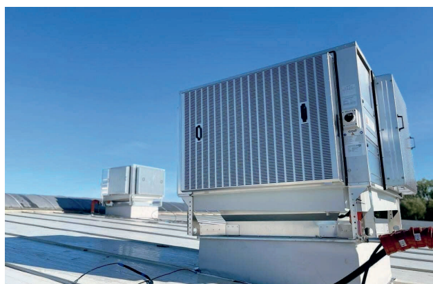
CoolStream S – jednostka nawiewna z połączeniem dolnym wraz z wywiewem mechanicznym typu Coltair
