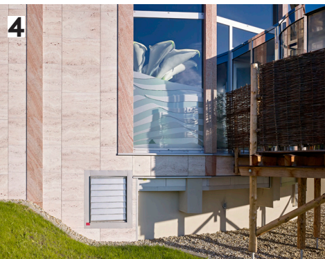
Afbeelding 3 & 4: Liberator WL-FCO/4 – afsluiteenheid in geopende en gesloten stand
