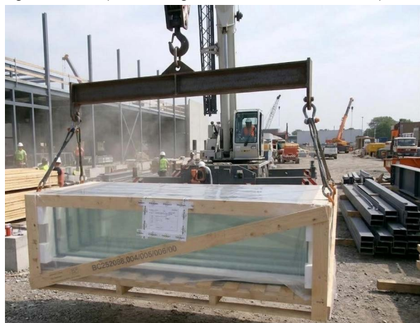
figure 8.2: Exemple de levage de la caisse à l'aide d'un dispositif de levage
