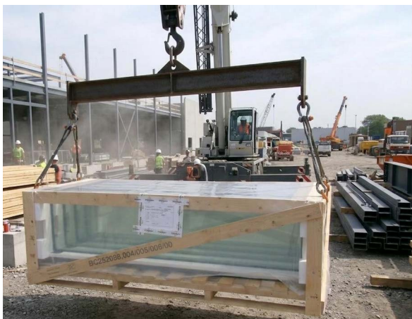
illustration 8.1: Exemple de soulèvement de la caisse avec un dispositif de levage
